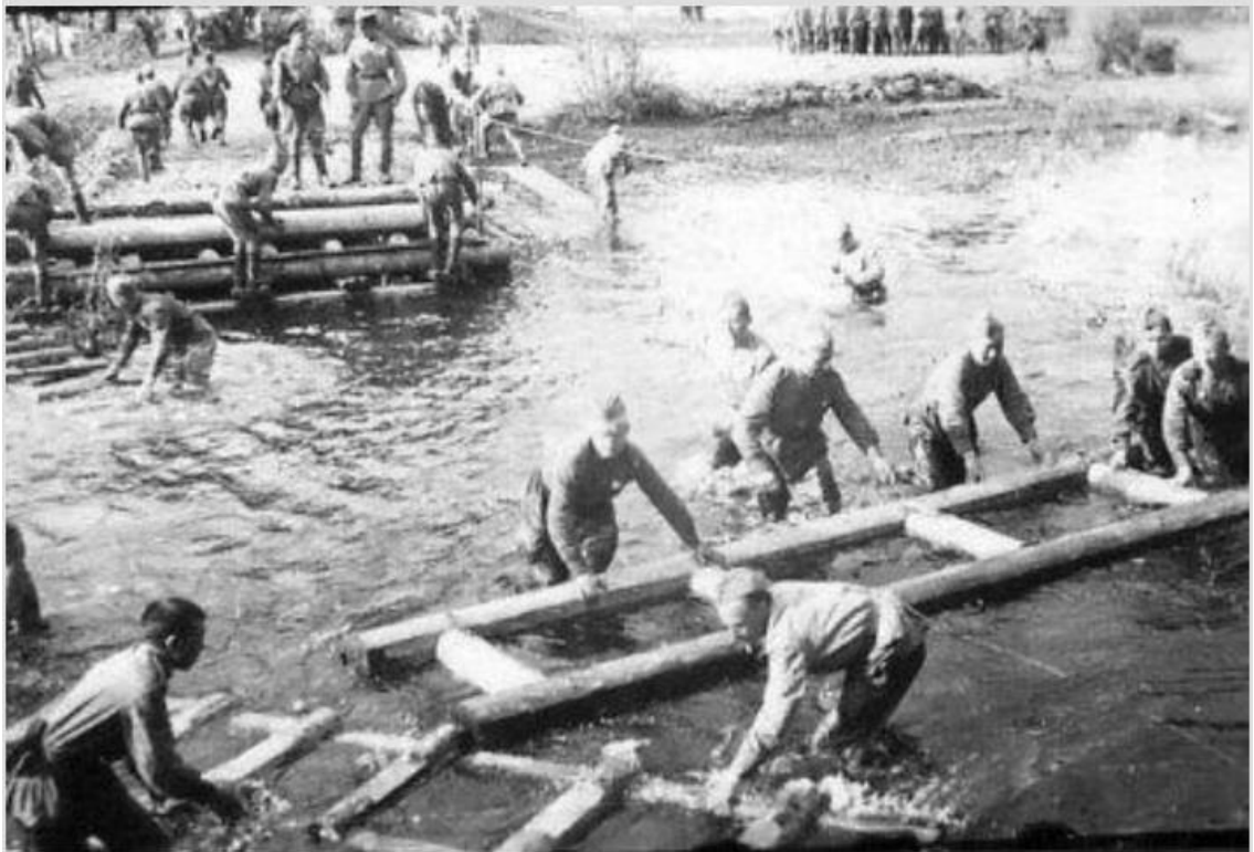
Наведение переправы на р. Полота (приток Западной Двины) в г. Полоцке
